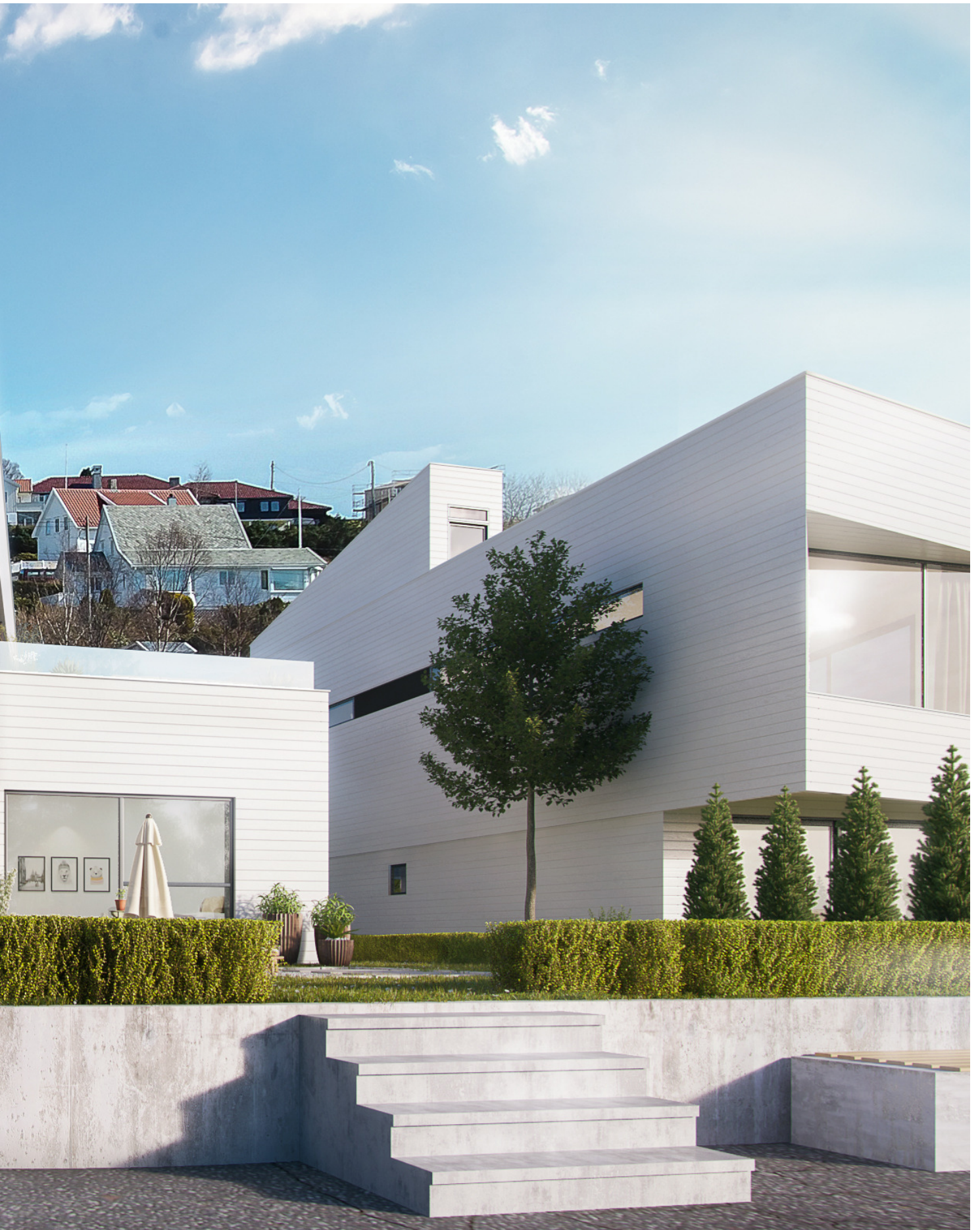
Moderne fasade. Det støpes betongtrapper som går utenfor tomtegrensen, for maksimal utnyttelse av tomtearealet.
